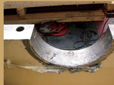
受损之轴承承托面后经喷焊修复
